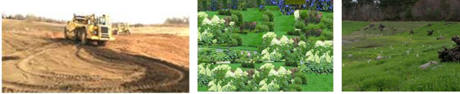
படம் 4. அகழ்வுக் குழிகளை நிரப்பதல் மற்றும் மறு சீரமைத்தல்
